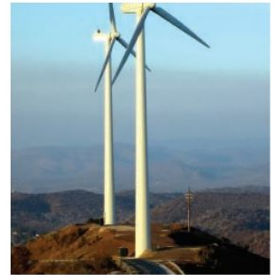
الشكل ٦ تعمل مراوح الهواء بنفس مبدأ منشآت الطاقة، وبدلاً من إدارة المحرك البخار يُدار بالمراوح التي تحركها الرياح.
