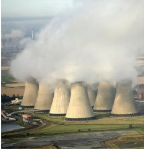
الشكل ٨ تستخدم محطة توليد الكهرباء أبراج التبريد لخفض درجة حرارة الماء الحار الناتج عنها.
